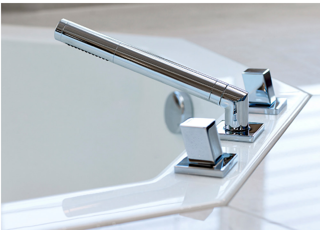
Wannenarmatur auf den Wannenrand montiert.
